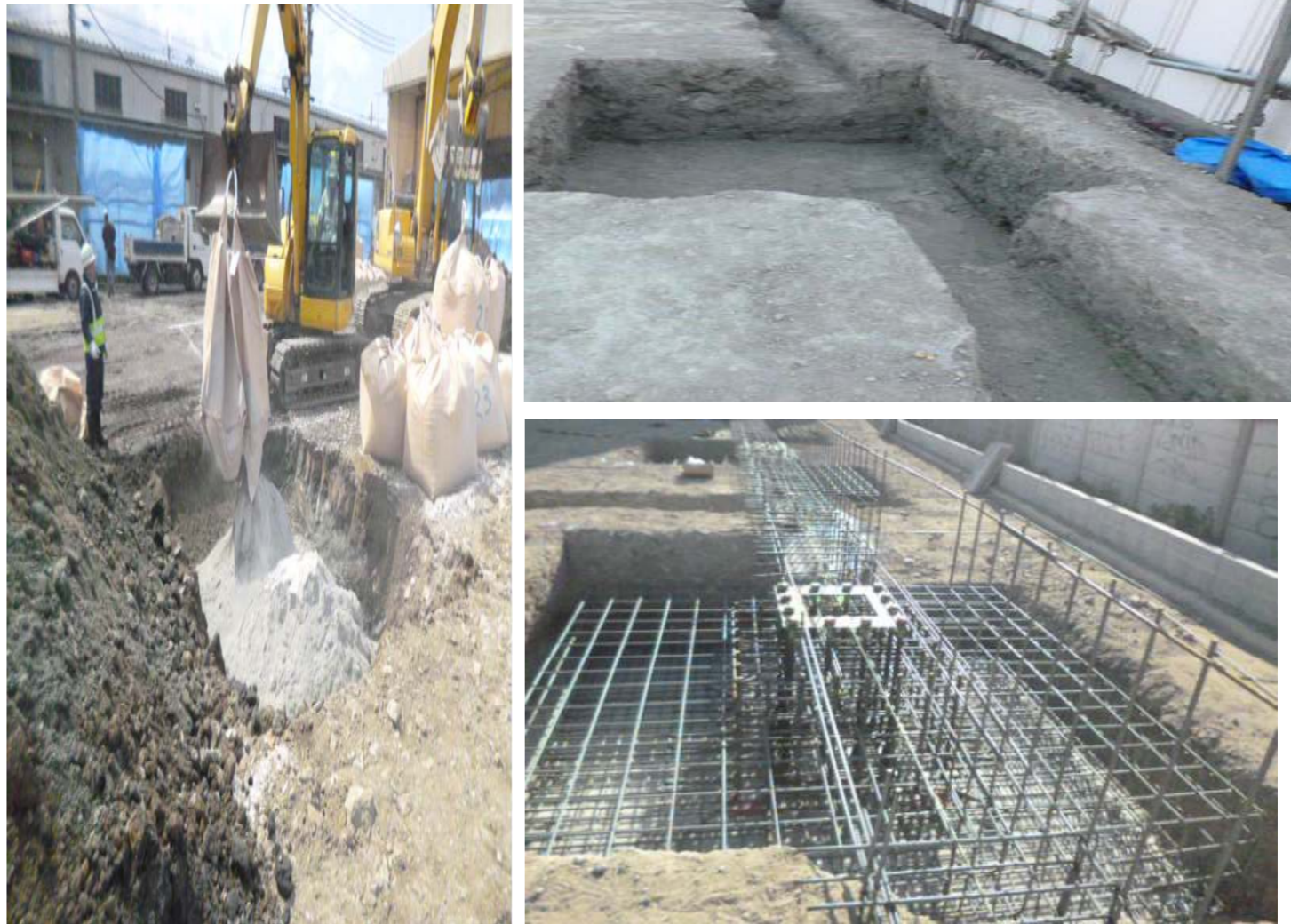
施工写真 (TNF施工完了後の配筋状況; 型枠なしで改良面を土型枠として使用している点にご注目ください。)
