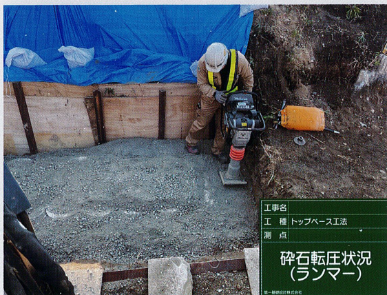
③ 碎石転圧
