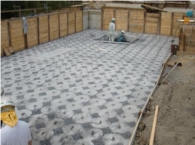
金閣寺境内改修工事 鉄骨造平屋
