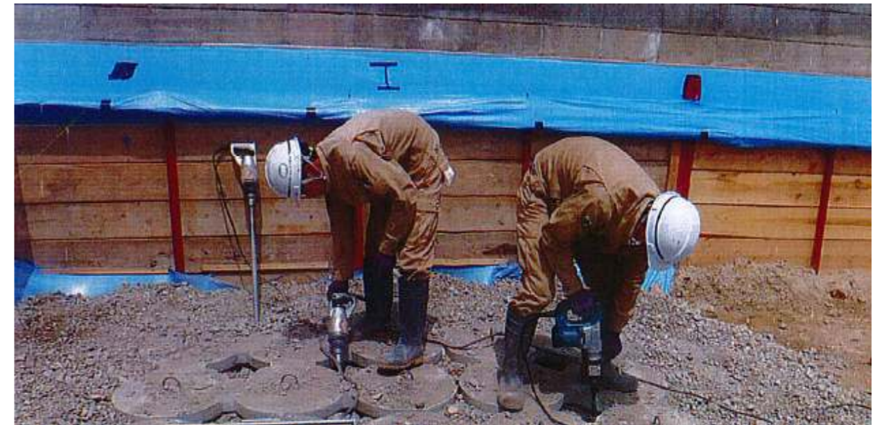
〈間詰砕石転圧状況〉
